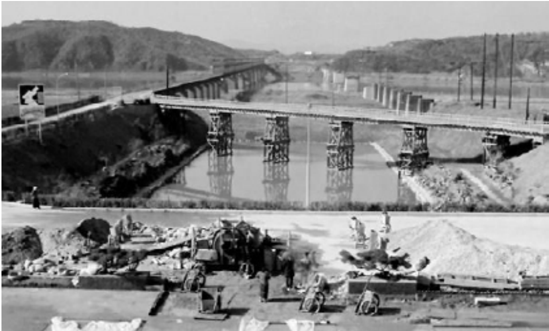
1970년대 임진각 광장 망배단설치공사
